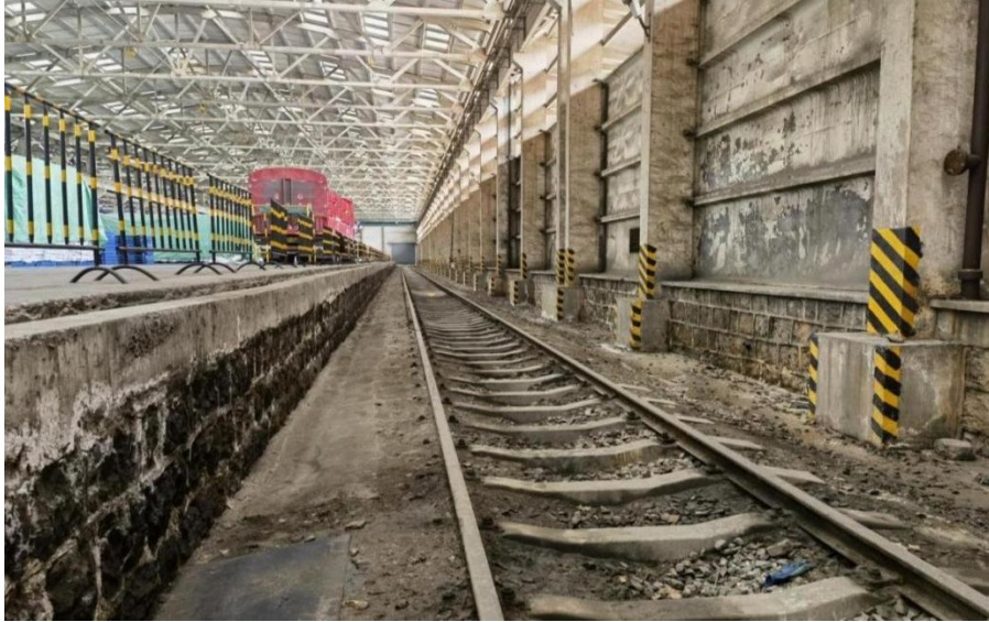
图 2-2 到达非罐装氢氧化钾卸车作业线（11道）现场
